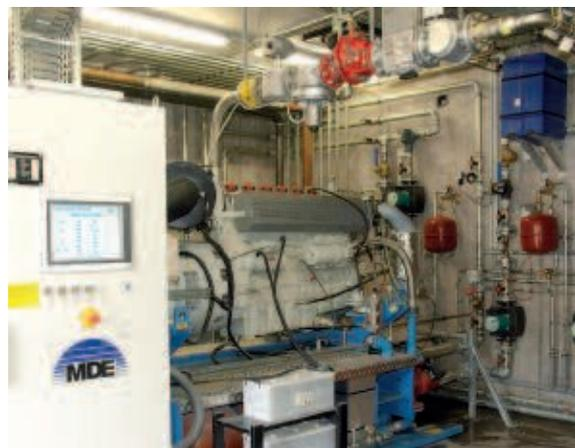
**Neben dem Gasmotor ist noch Platz für eine Biogasaufbereitung. Alle Anschlüsse wurden bereits eingebaut.**
